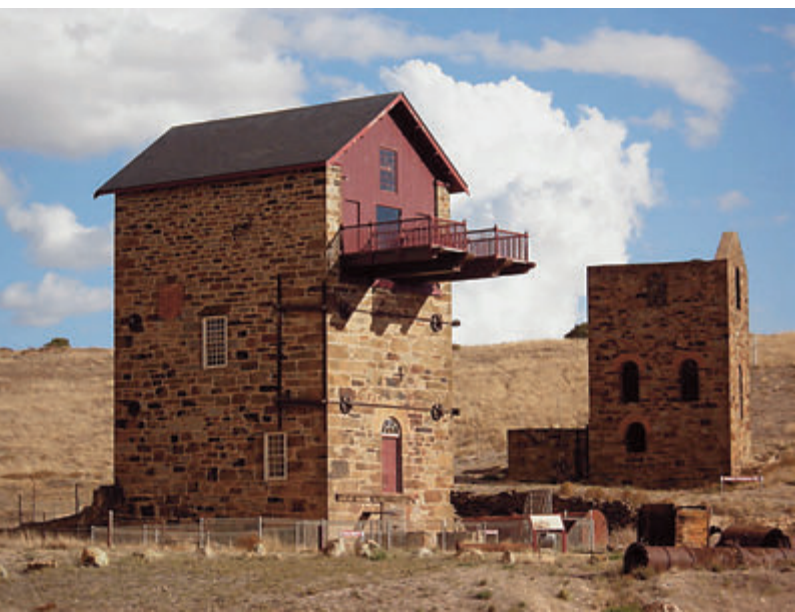
Cornische Maschinenhäuser bei Burrup, Südastralien. Überreste einer Kupfermine aus der Mitte des 19. Jahrhunderts.
